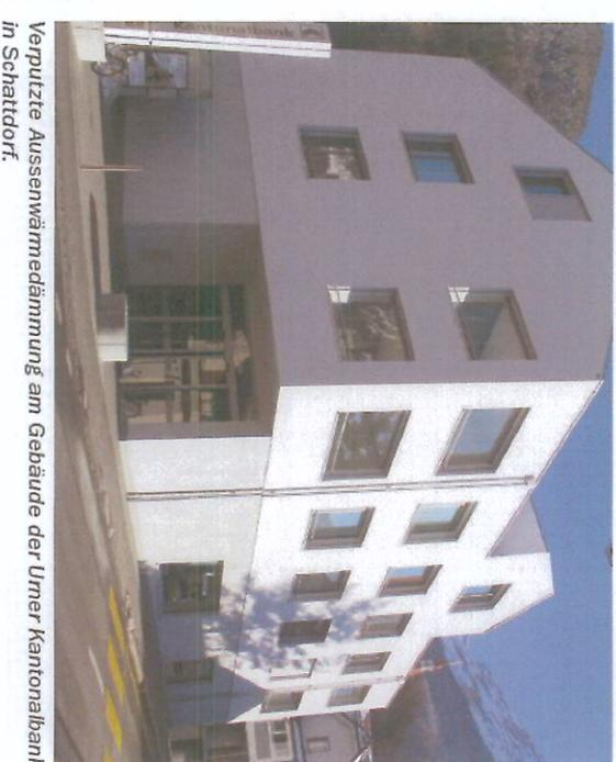
Verputzte Aussenwärmmedämmung am Gebäude der Uner Kantonalbank in Schattdorf.
